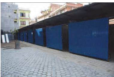
Insges. 15 Behelfs-Klassenräume für die Panga H.S.S
