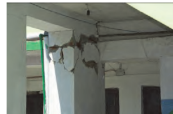
Sanierung des 4-geschossigen Schulgebäudes mit schweren Beschädigungen an der Gebäude-Struktur
